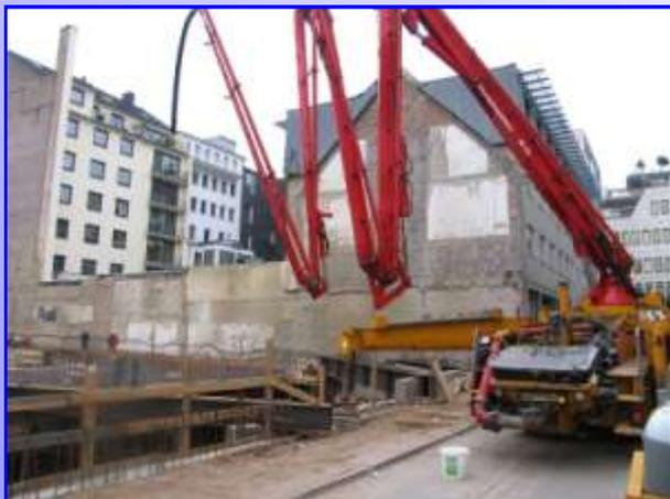
1. Se despliega la trompa de la bomba.
